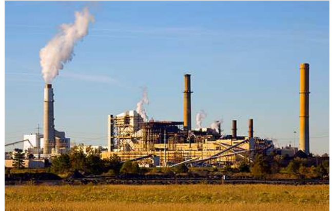
Rysunek 7. Elektrownia Chesterfield należąca do Consortium Dominion
